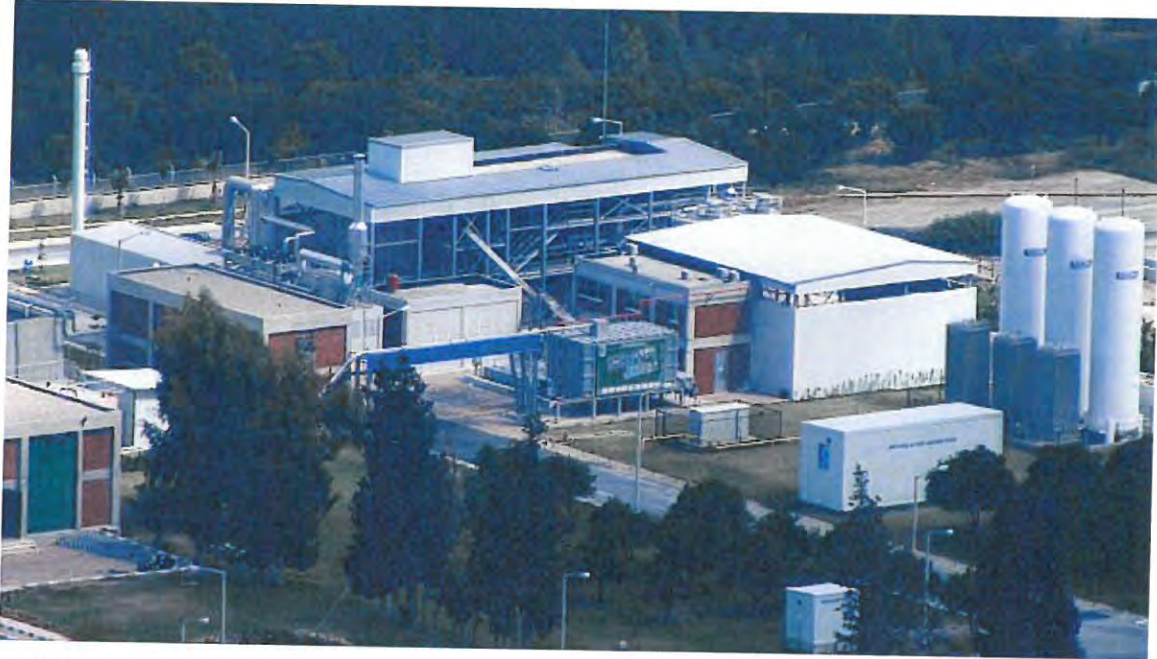
Resim 3.Arıtma Çamuru Termal Kurutma ve Kojenerasyon Tesisi
